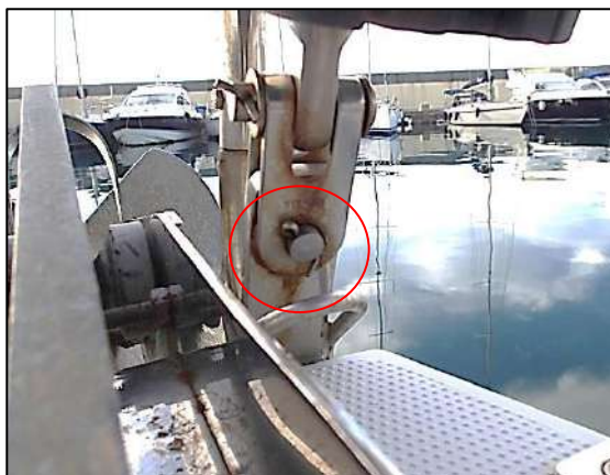
Photo 4 : cisaillement de la goupille en cours
